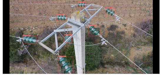
FIGURE 1 – Exemple de détection d'isolateurs par Yolov5m6.
